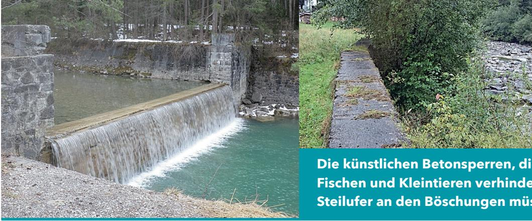
**Die künstlichen Betonsperren, die bisher eine Wanderung von Fischen und Kleintieren verhindern, sowie die betonierten Steilufer an den Böschungen müssen entfernt werden.**
